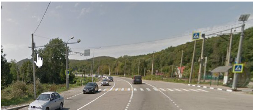
Рис. 10. Пример установки дорожных радаров с сигналами для водителей на подъезде к г. Горячий Ключ
