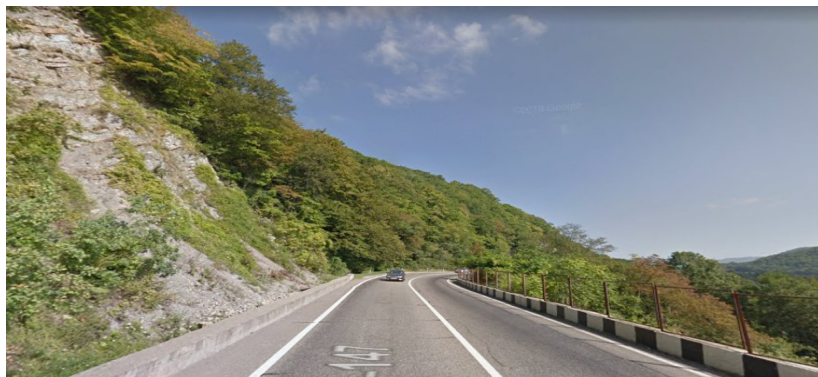
Рис. 2. Пример участка федеральной трассы «Дон»
